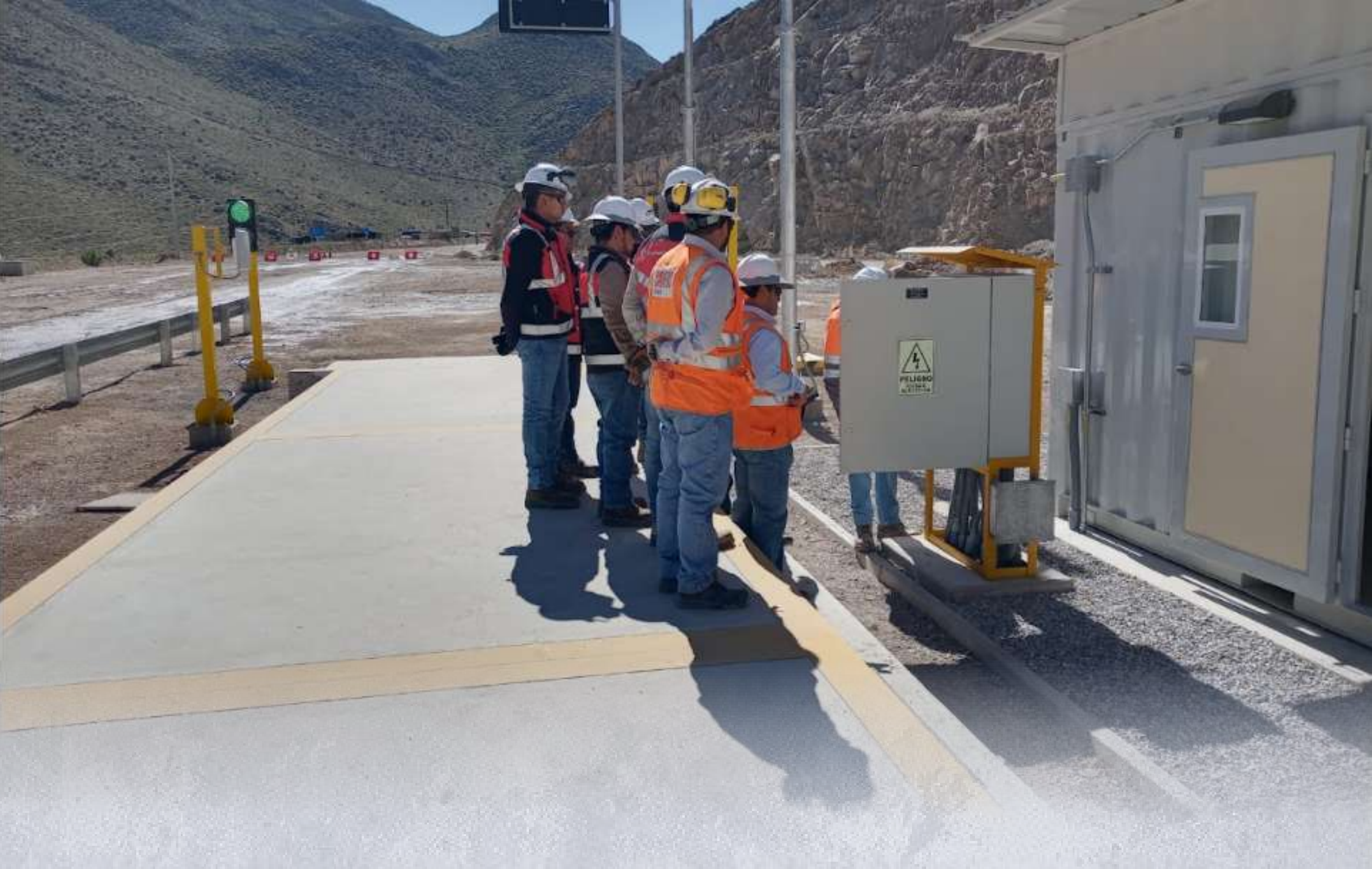
TRABAJOS DE PRECONDICIONAMIENTO PARA PUESTA EN MARCHA DE BALANZA
