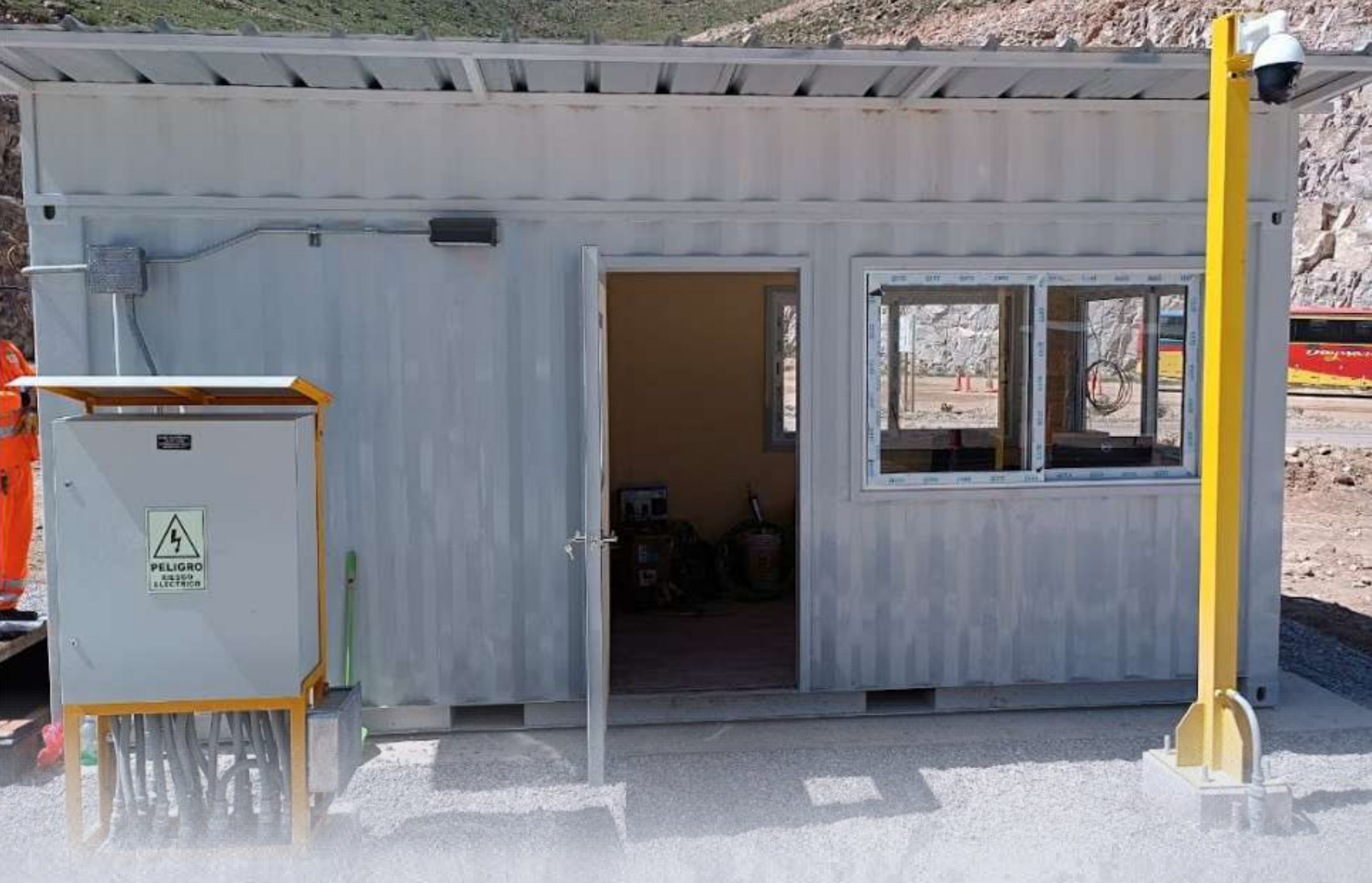
CASETA DE CONTROL BALANZA
